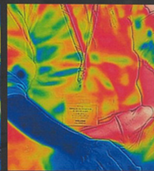
フィルム未施工
